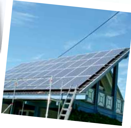
Frittlingen / Müstakil Ev - ALMANYA Kurulu Güç : 11,16 kWp Modül Sayısı : 62 Modül Tipi : Polikristal (180 W)
