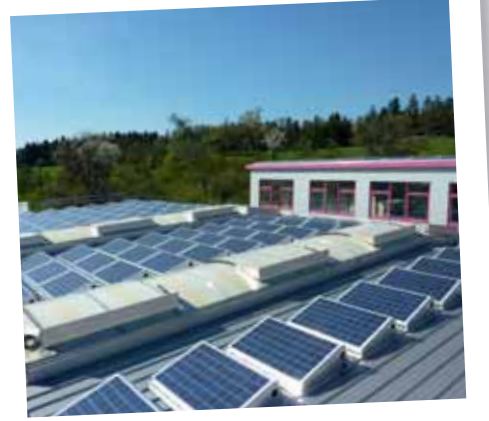
Koch / Ratshausen - ALMANYA Kurulu Güç : 500 kWp Modül Sayısı : 2084 Modül Tipi : Polikristal (240 W)
